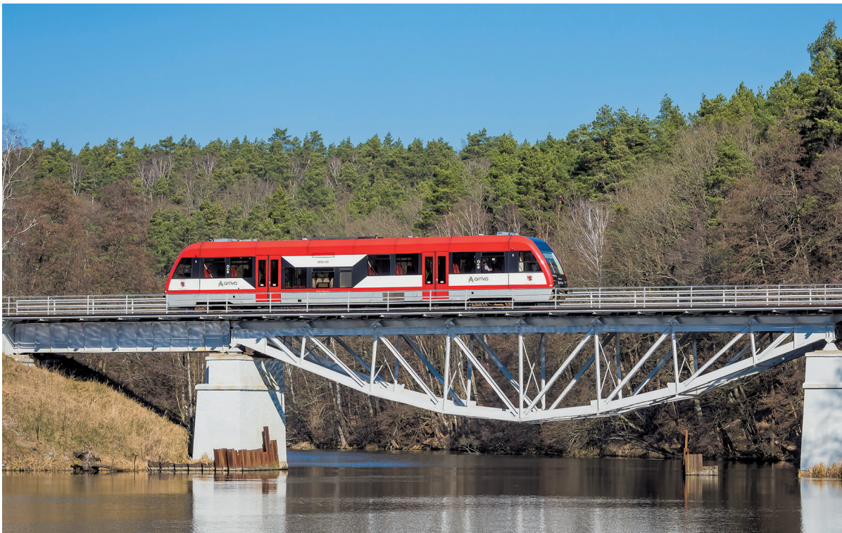
Most kolejowy w Tleniu. Fot. Tomasz Czachorowski./eventphoto.com.pl dla UMWKP
