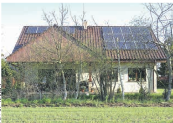
Wśród kluczowych zadań inwestycyjnych planowanych przez gminy znalazł się m.in. montaż instalacji fotowoltaicznych.
