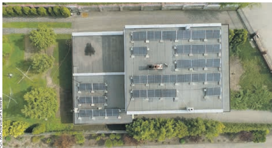
Instalacje fotowoltaiczne na naszych domach to już nie luksus, a potrzeba chwili.
