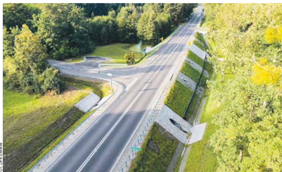
Prace toczyły się na odcinku około 8 km.
