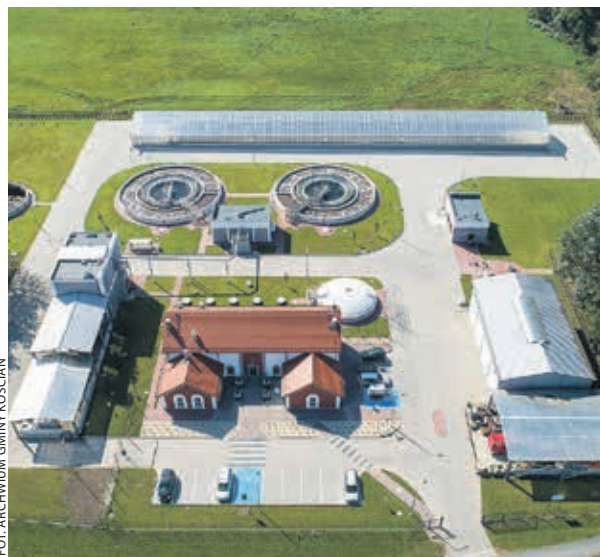
Rozbudowana oczyszczalnia w Racocie „z lotu ptaka”.
