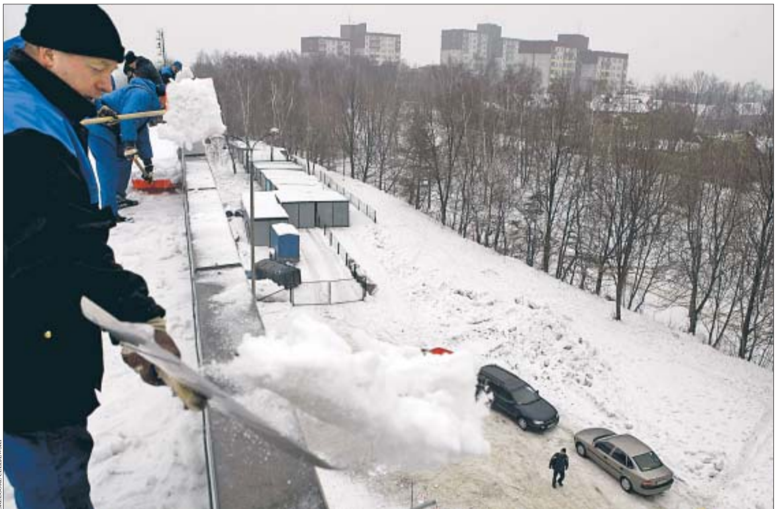
Poniedziałek 30 stycznia 2006 r., godz. 11. Usuwanie śniegu z dachu lodowiska w Tychach
