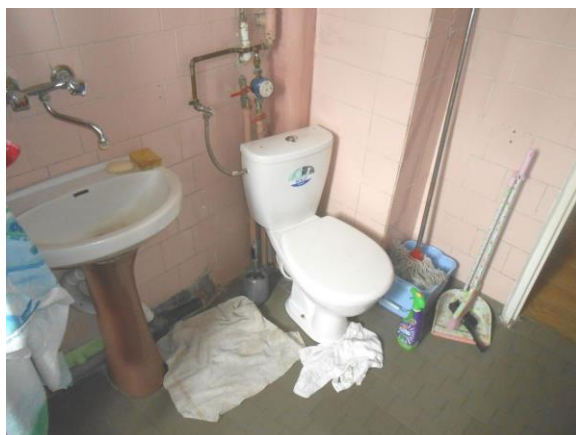
Fot. 20. Widok ogólny łazienki
