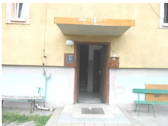
Fot. 6. Widok wejścia do wspólnej klatki schodowej
