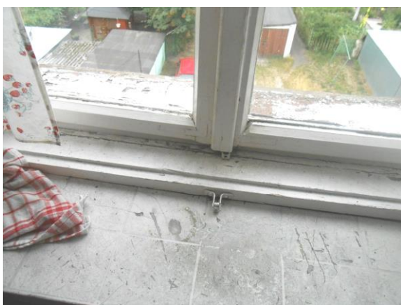
Fot. 11. Stan stolarki okiennej w lokalu
