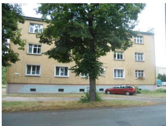
Fot.4. Widok budynku wielorodzinnego
