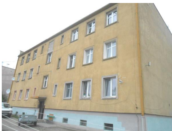
Fot. 2. Widok ogólny budynku mieszkalnego nr 3
