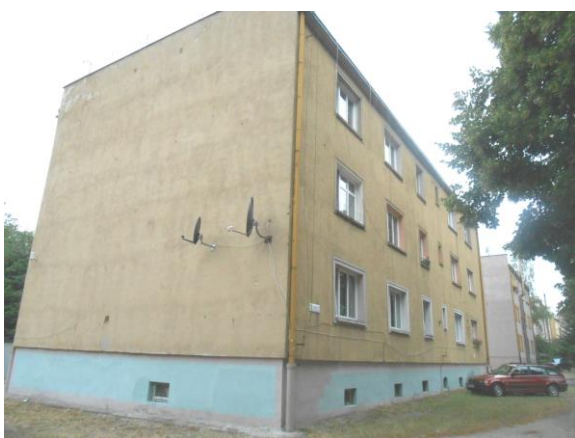
Fot.3. Widok budynku wielorodzinnego
