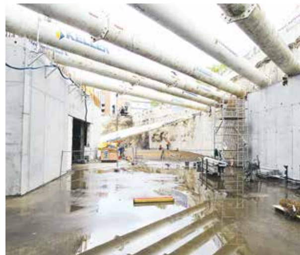
Pierwszy rok prac zdominowały roboty pod ziemią.
