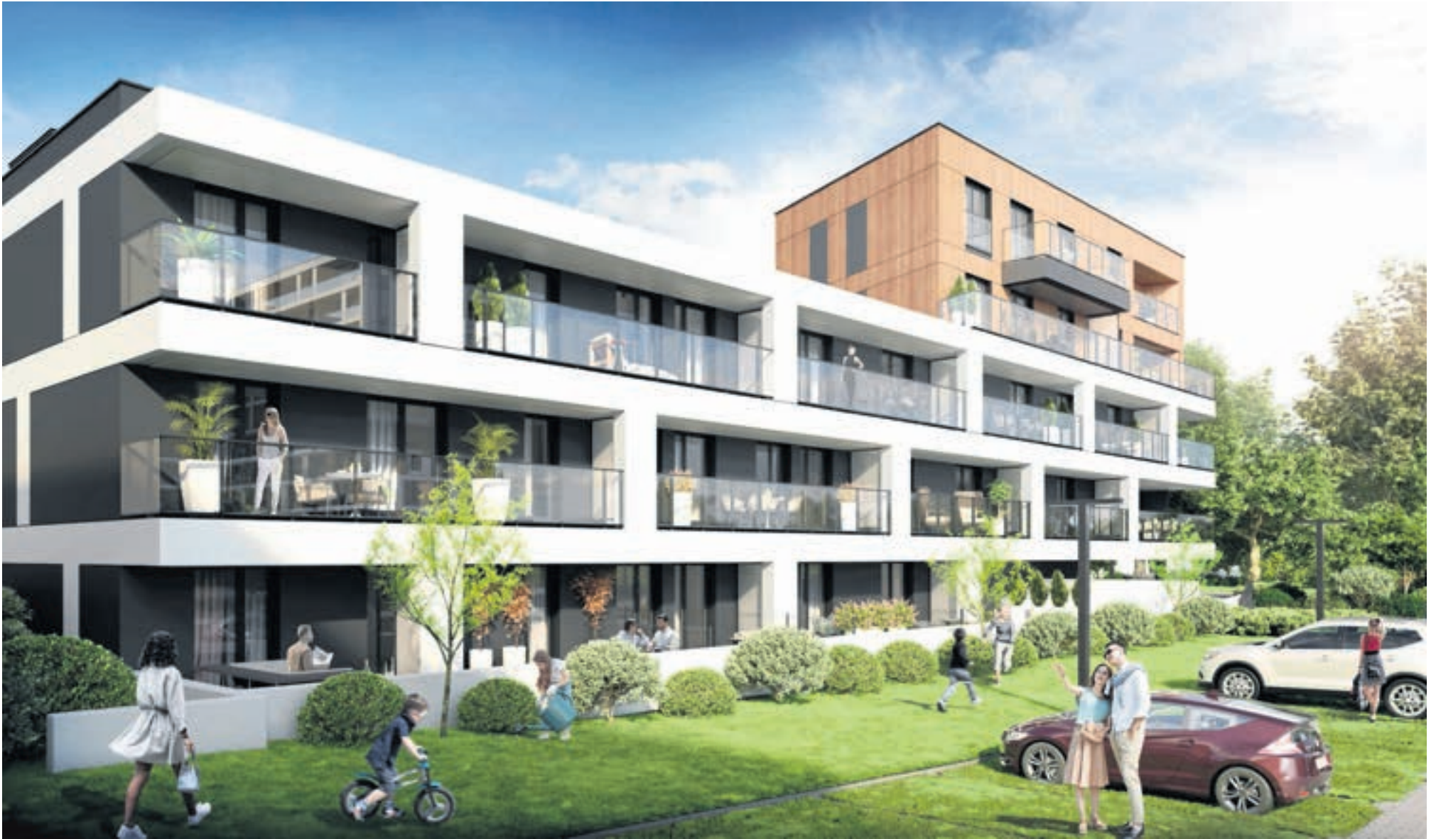
• Orkana Residence II etap FOT. MATERIAŁY PRASOWE
