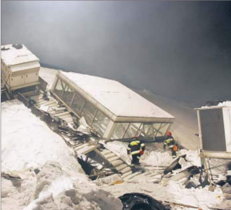
Hala wystawiennicza nr 1, największa w kompleksie MTK, miała prawie 10 tys. m kw. Jej konstrukcja była lekka, wykonana głównie ze stali, a dach – z blachy. Na zdjęciu: akcja ratownicza, godz. 20.29
