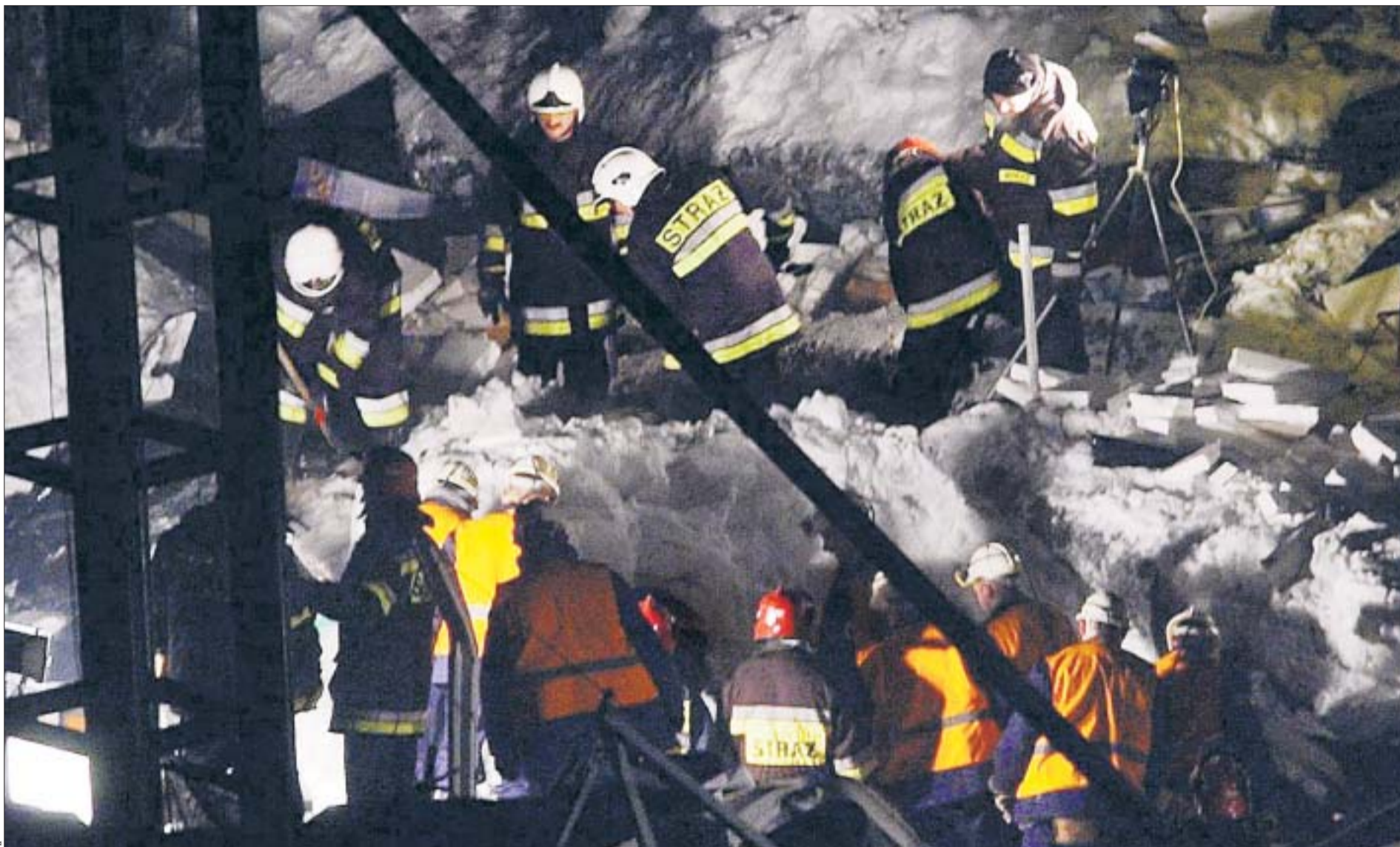
Niedziela, ok. 1 w nocy, ruiny hali nr 1 Międzynarodowych Targów Katowickich. Strażacy odkopują śnieg z rumowiska w poszukiwaniu ofiar. Temperatura spadła wtedy do -15 stopni
