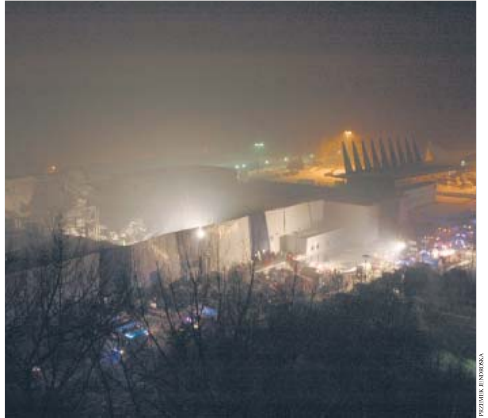
Według prokuratury na dachu mogło zalegać nawet 2,5 tys. ton śniegu i lodu. Mówi inż. Zbigniew Łomnicki, konstruktor hal: – Już w grudniu, kiedy zawaliło się w Polsce kilka dachów, należało podnieść alarm i zmusić wszystkich administratorów budynków do zrzucenia śniegu. Na zdjęciu: akcja ratownicza, godz. 20.35
